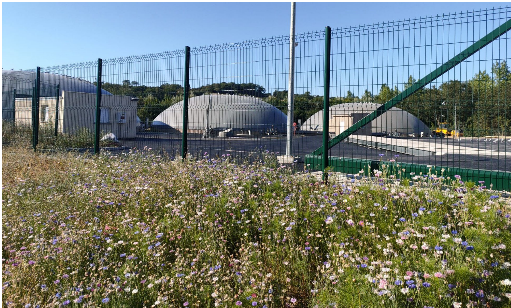
Figure 45. Photographie de l'aménagement de bandes fleuries autour du site de méthanisation
